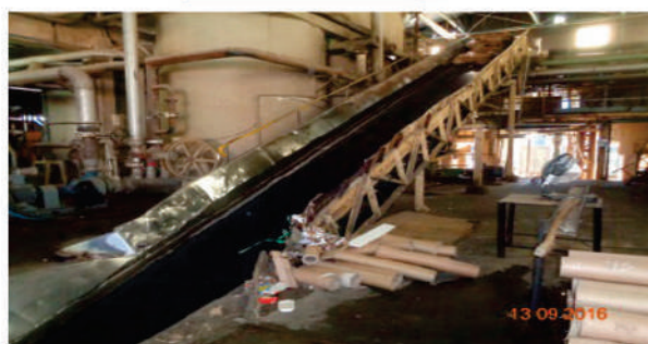
Adequação do guarda-corpo e escada da esteira inclinada
